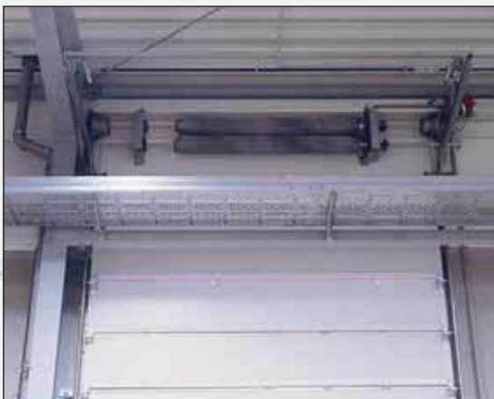
T30 Sectionaltor mit höhergeführtem Laufschienebeschlag.
